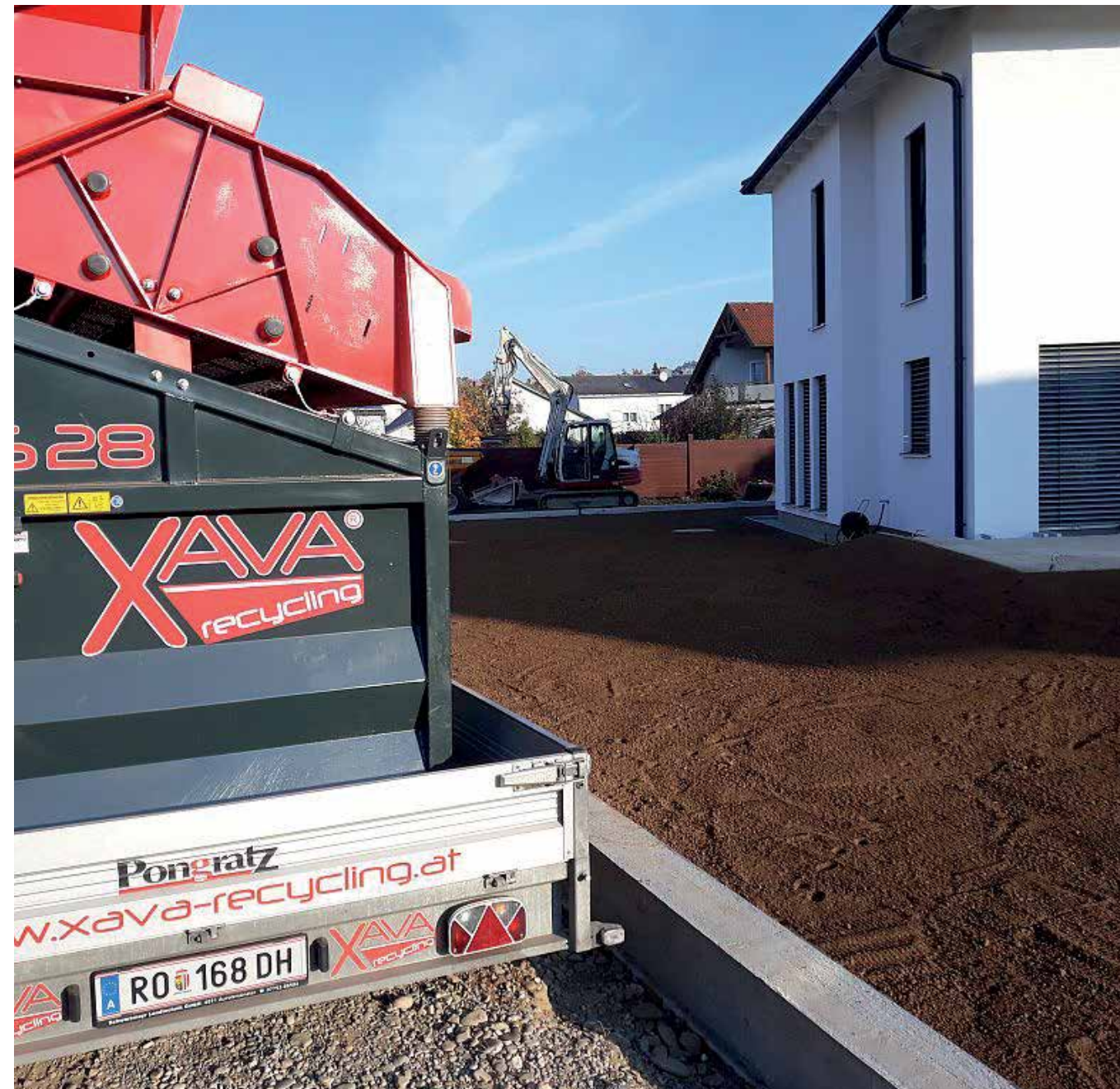
Feine Erde, abgeseibt auf 0-10mm und befreit von Wurzeln und Steinen zur ökonomischen Wiederverwendung im Gartenbau. Mit Hilfe des Rüttelsiebs LS28 konnte dieser 600m 2 Garten in 1,5 Tagen völlig neu angelegt werden.
